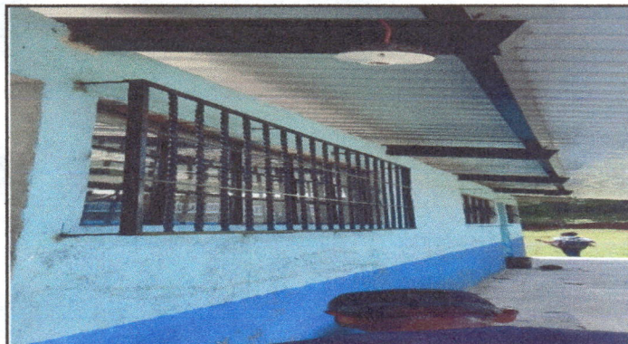
Foto 4: evidencia la culminacion de la colocacion de balcones del modulo II
