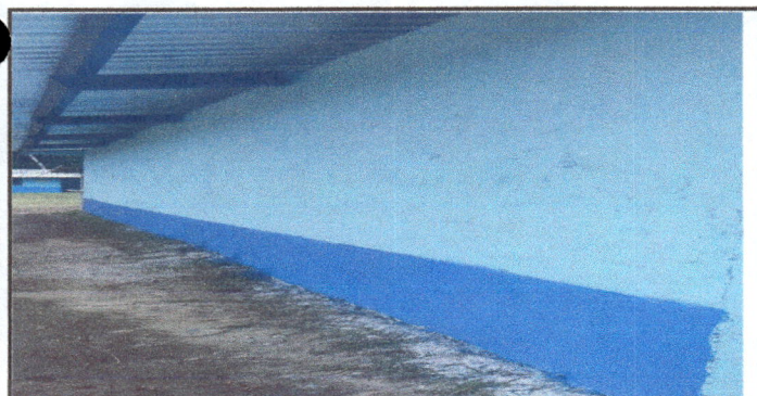
Foto 5: Evidencia de la culminacion de colocacion de la pintura del modulo I
