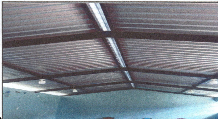
Foto1: Se evidencia la culminacion del cambio de entechado y colocacion de laminas del modulo I
