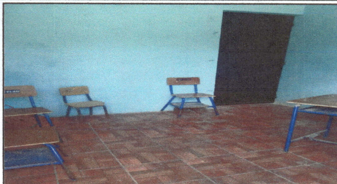
Foto 2: Se evidencia la culminacion de rehabilitacion de la division del modulo II
