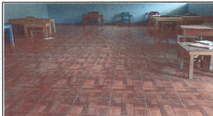
Foto 3: Imagen que evidencia la culminacion de sustitucion del piso de torta por piso ceramico.
